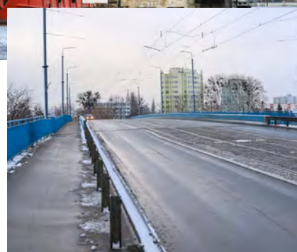
Most Siennicki po przebudowie w latach 2014–2015
