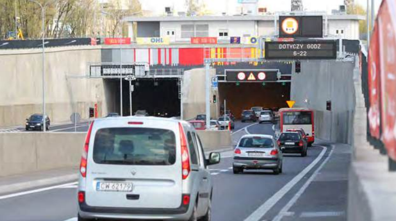
Oficjalne otwarcie tunelu pod Martwą Wisłą dla ruchu samochodowego nastąpiło 24 kwietnia 2016 r.
