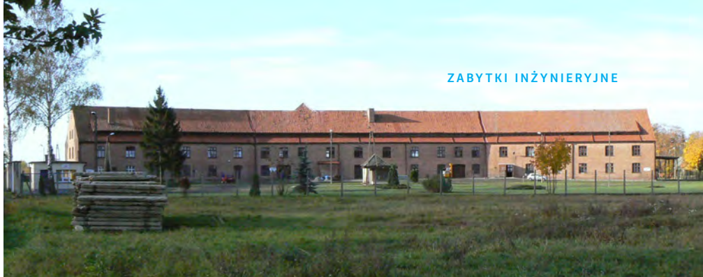
Zbudowany w dwudziestoleciu międzywojennym w Sadlinkach budynek wstępnej obróbki liści tytoniowych na potrzeby przemysłu tytoniowego
