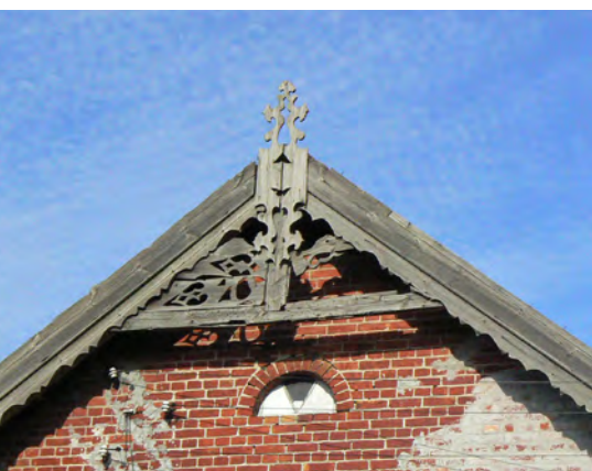
Dekoracyjnie opracowane wiatrownice szczytu, pazdur oraz laubzekinowe wypełnienie wierzchołka szczytu domu mieszkalnego w Okrągłej Łące, z początku XX w.
