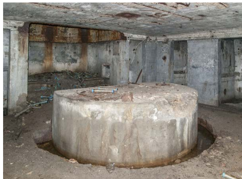
Wnętrze najlepiej zachowanego schronu kierowania ogniem baterii Wiejskiej
