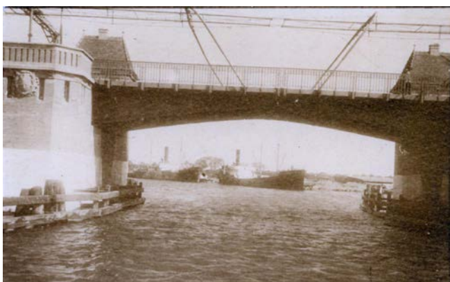
Most Siennicki – przęsło zwodzone w latach 1927–1945, widok od strony północnej
