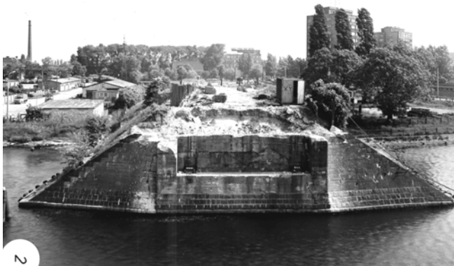
Most Siennicki w trakcie rozbiórki, przyczółek i dojazd od strony Stogów – 1988 r.
