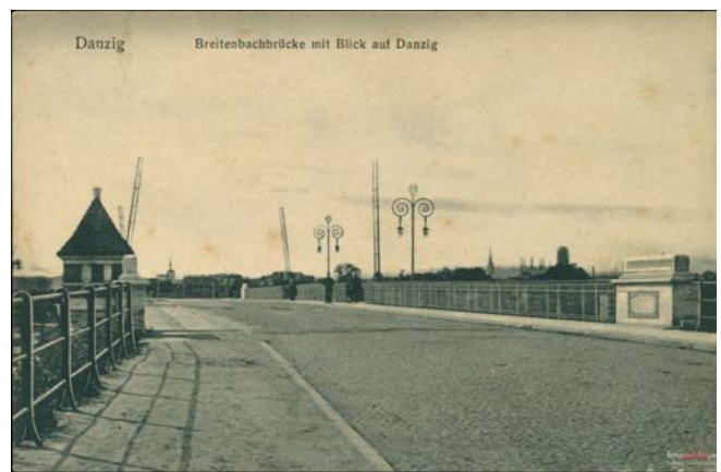
Most Siennicki w latach 1912–1927 – wjazd na most od strony Stogów
