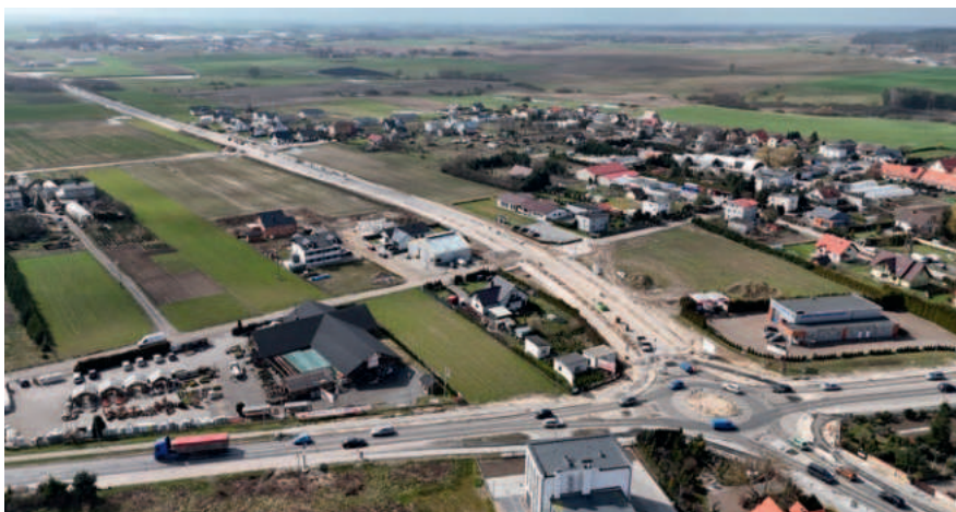
Budowa zachodniego obejścia Chojnic
