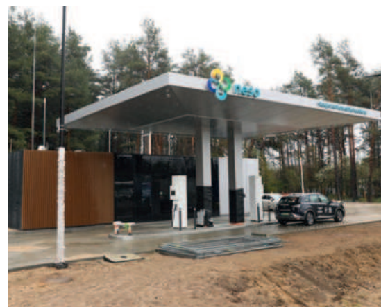
Stacja tankowania wodoru budowana w Gdyni
