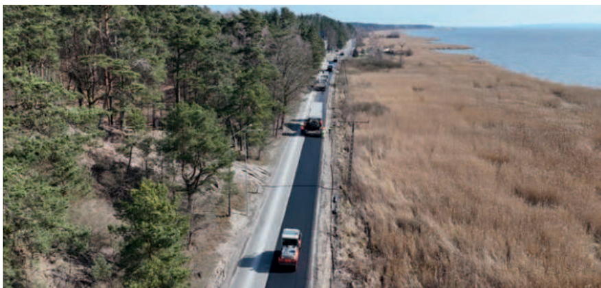
Przebudowa drogi na odc. Stęгна – Krynica Morska
