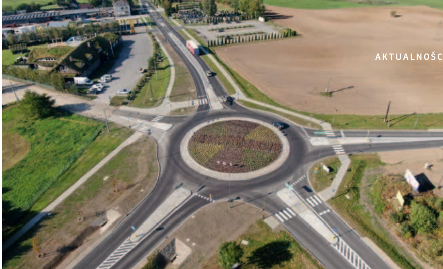
Przebudowana droga w Starej Kiszewie
