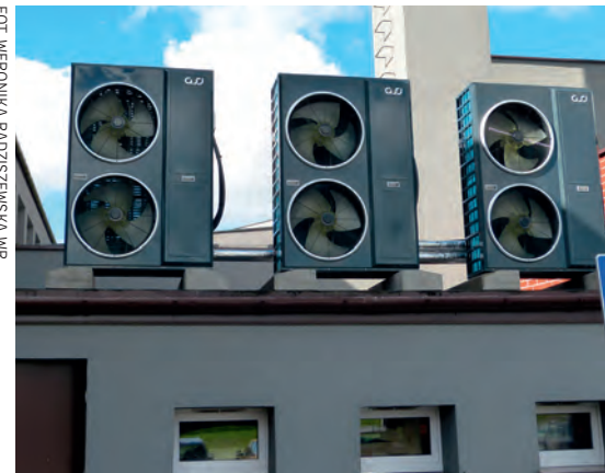
Pompy ciepła w Przywidzu
