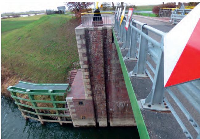
Węzeł wodny w Białej Górze – wrota powodziowe
