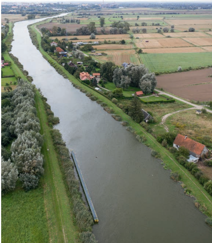
Rzeka Elbląg przed rozpoczęciem prac hydrotechnicznych (wrzesień 2020 rok) Fot. Sławomir Lewandowski
