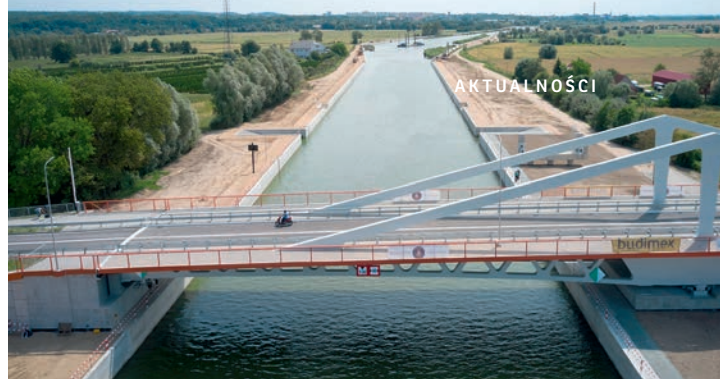
Nowy most z widoczną obudową brzegów wykonaną w ramach tej samej inwestycji Fot. Urząd Morski w Gdyni
