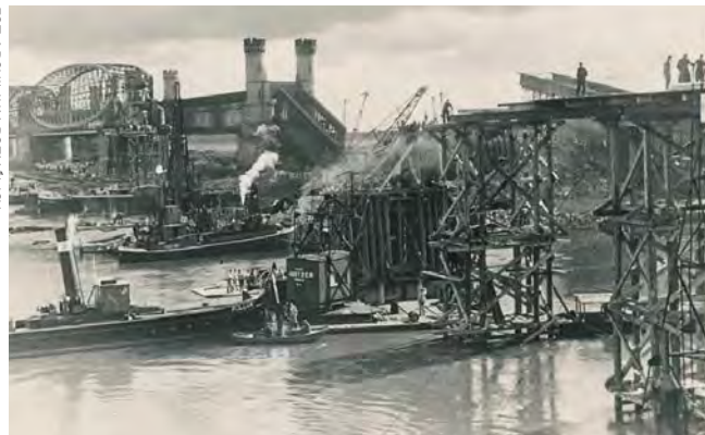
Odbudowa mostu kolejowego w 1940 r.
