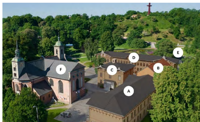
Szczegółowy opis budynków zespołu poszpitalnego pod Górą Gradową w artykule
