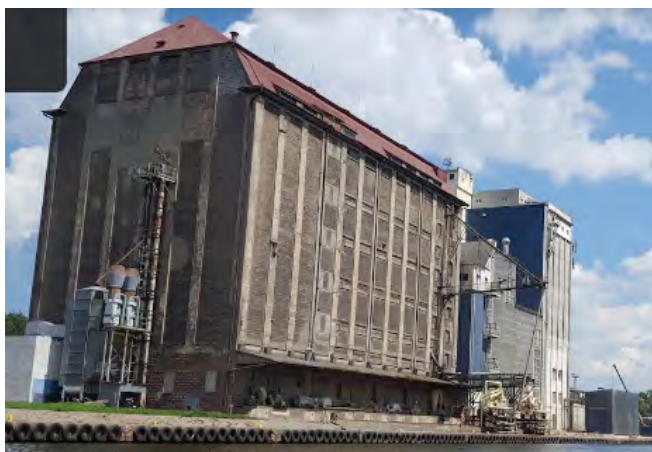
Silos Gdańskie Młyny - widok od strony Martwej Wisły
