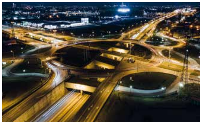
Fot. 3. Wjazd do tunelu pod Martwą Wisłą od strony ul. Marynarki Polskiej w Gdańsku
