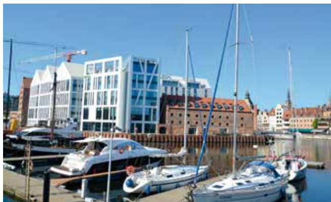
Fot. 2. Zabudowa północnego cypla Wyspy Spichrzów od strony Nowej Motławy w Gdańsku
